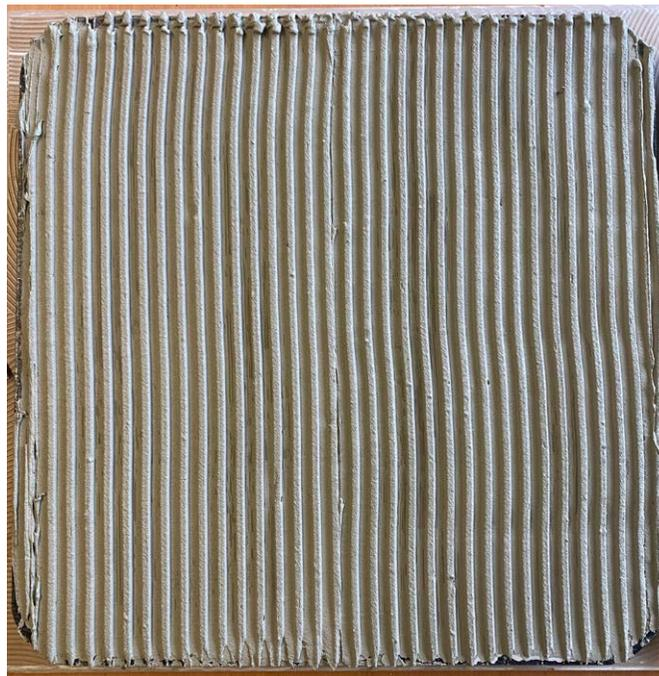
Aufbringen des Klebers (Flexmörtel schnell, 1k oder 2k Kartuschenkleber)
