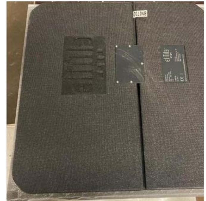
Fixierung des Heizmoduls an der Fliesenunterseite
