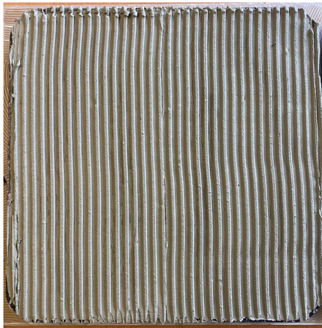
Aufbringen des Klebers (Flexmörtel schnell, 1k oder 2k Kartuschenkleber)
